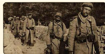
Le ravitaillement en soupe de la tranchée
